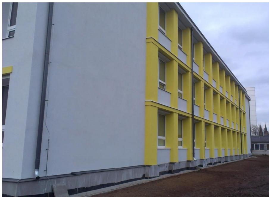
Obr 19: Okapy prvního pavilonu školy (Dozoring s.r.o., 2023)
