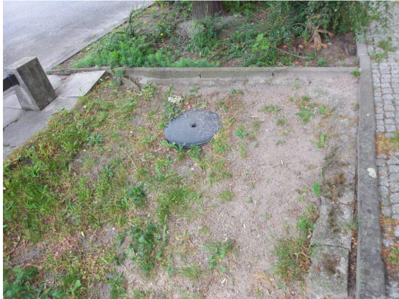
Obrázek 10: Bezpečnostní svod do kanalizace (pocitamesvodou.cz, 2022)
