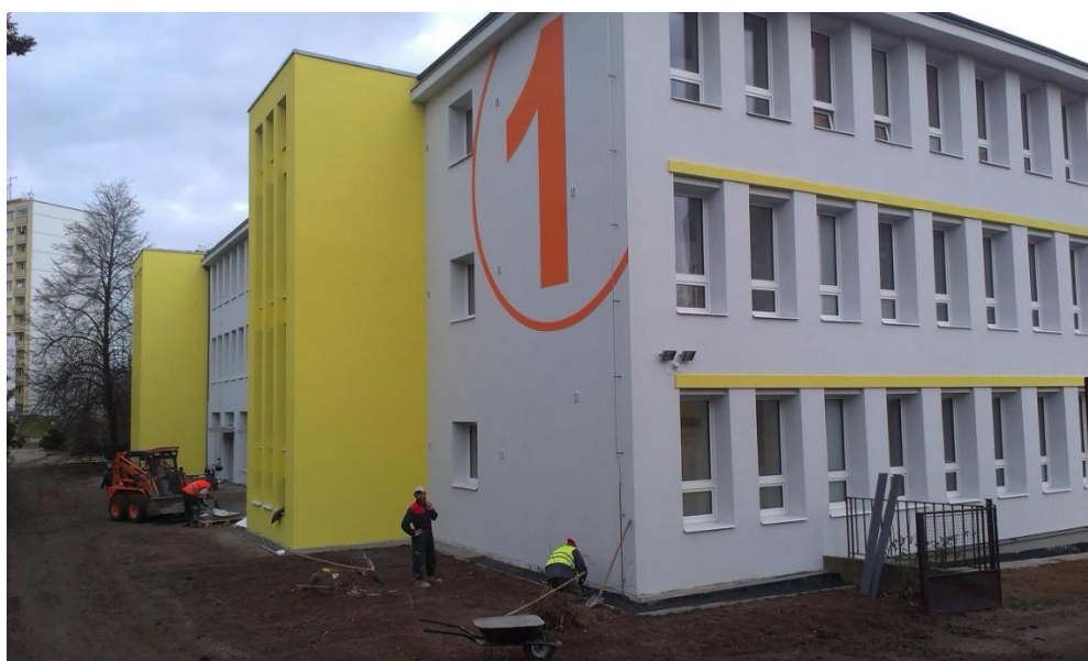
Obrázek 14: Pohled na základní školu (Dozoring s.r.o., 2023)
