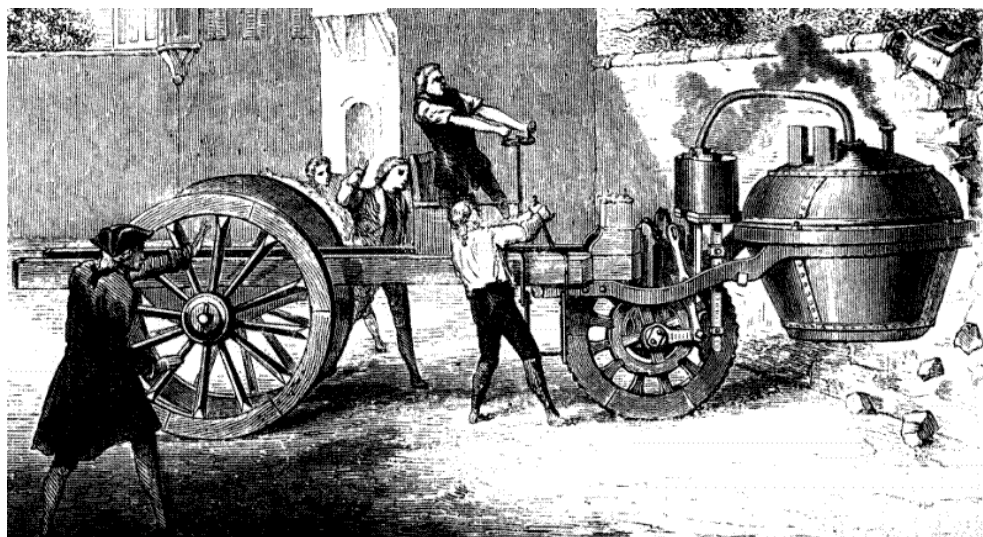
Obr. 3 Parní traktor N. J. Cugnota, který se zúčastnil první doložené dopravní nehody (6)
