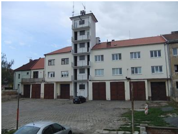
Příloha 8 - Požární stanice HZS Kralupy nad Vltavou
