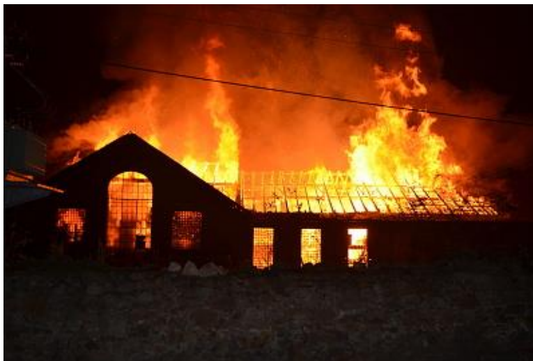
Příloha 3 - Požár bývalého cukrovaru Zákolany v plném rozsahu. Pohled z hlavní silnice směr Kladno. Foto: HZS Kladno
