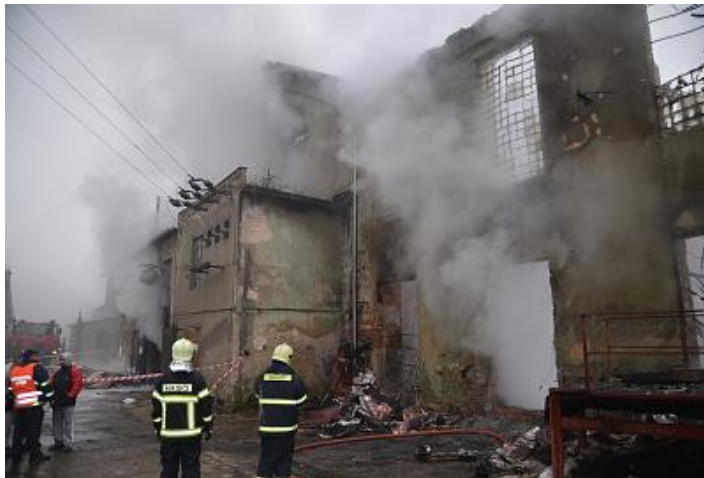
Příloha 5 - Požár bývalého cukrovaru Zákolany po lokalizaci požáru.
