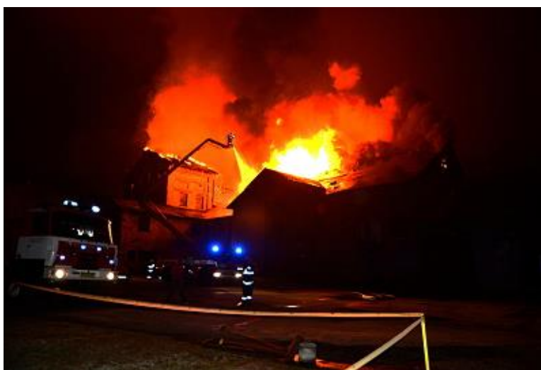
Příloha 4 - Požár bývalého cukrovaru Zákolany v plném rozsahu. Pohled z odstavné plochy. Foto: HZS Kladno
