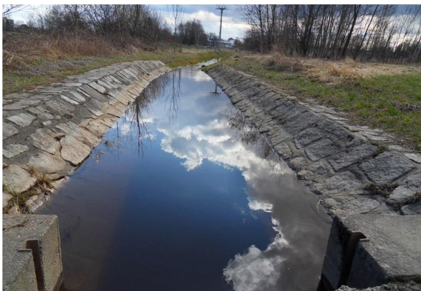
Obr. 16: Regulované koryto Zlaté stoky se zpevněnými břehy a dnem (Foto: P. Blabolil).
