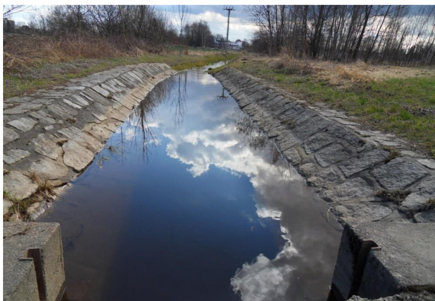
Obr. 16: Regulované koryto Zlaté stoky se zpevněnými břehy a dnem (Foto: P. Blabolil).
