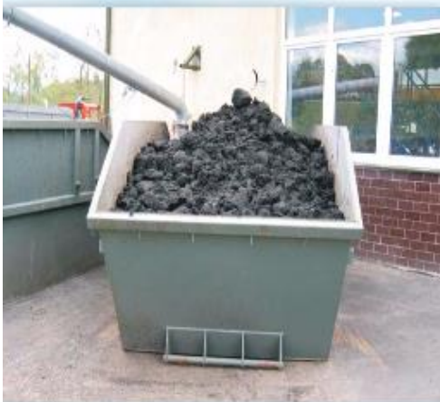
Vykládání kalu v čistírně odpadních vod
