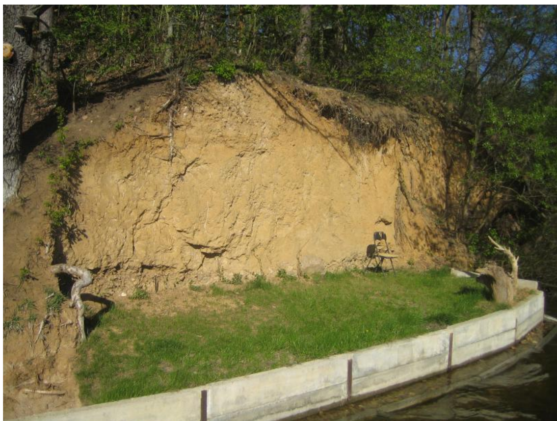
Obr. 2.1.1.2 Stabilizace pomocí betonových obrubníků, dospání zeminou, zatravnění
