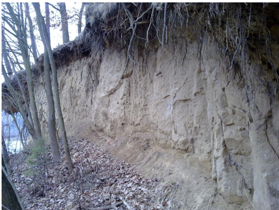
Obr. 2.1.1.10 Poškozený břeh, abraze 2. Stupně
