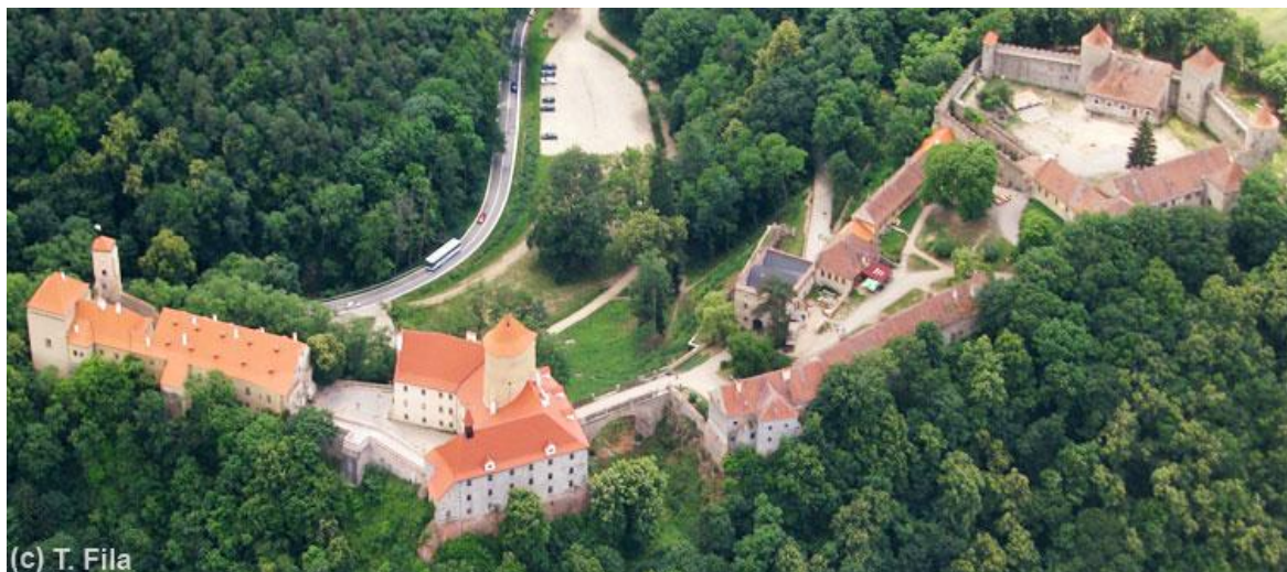
Obr. 1.13. Hrad Veveří v roce 2008, probíhající rekonstrukce objektu [9]
