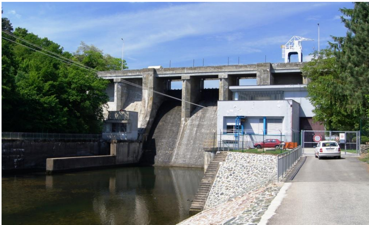
Obr. 1.10.1 Pohled na betonovou tížnou přehradu v Kníničkách, vpravo MVE Kníničky [12]
