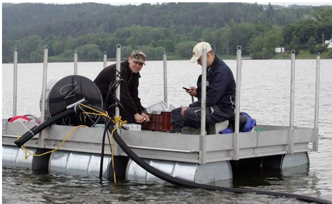
Obr. 1.12.2 Instalace aeračních věží pod hladinu nádrže [8]
