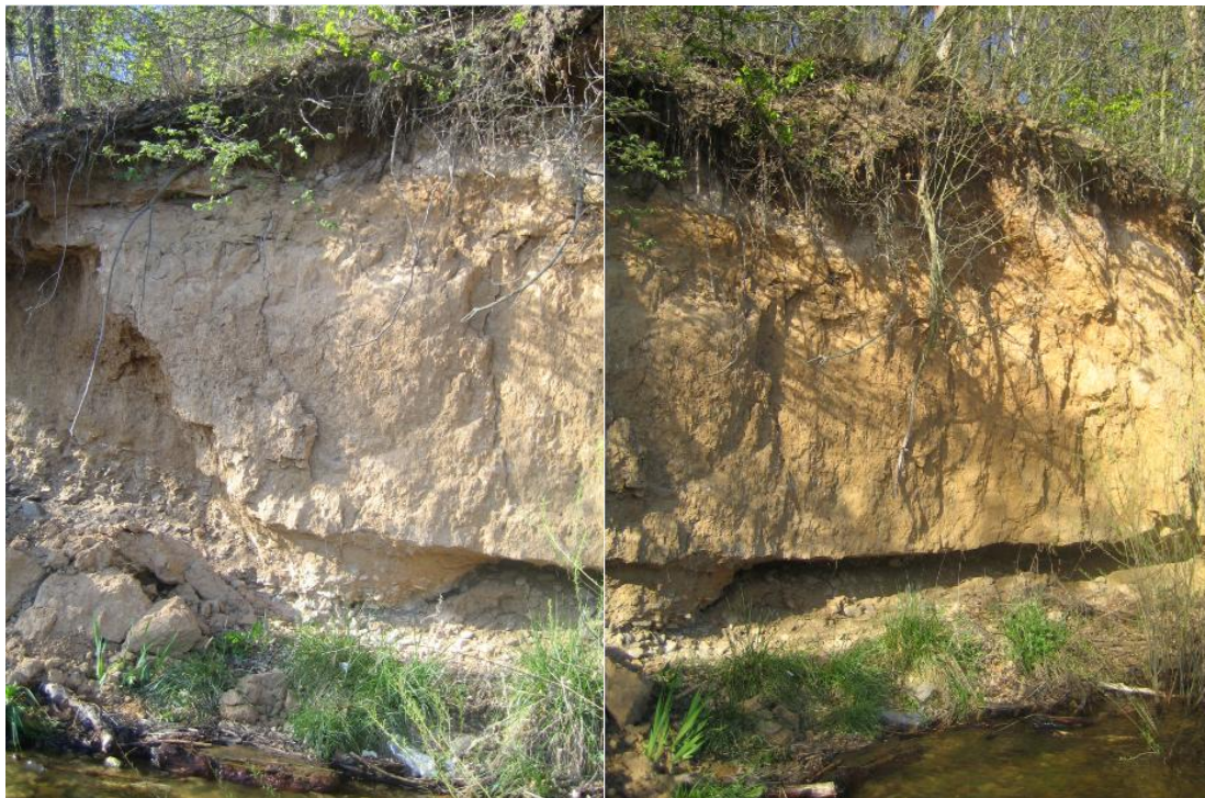
Obr. 2.1.1.5 Abrází poškozený svah, před sesuvem
