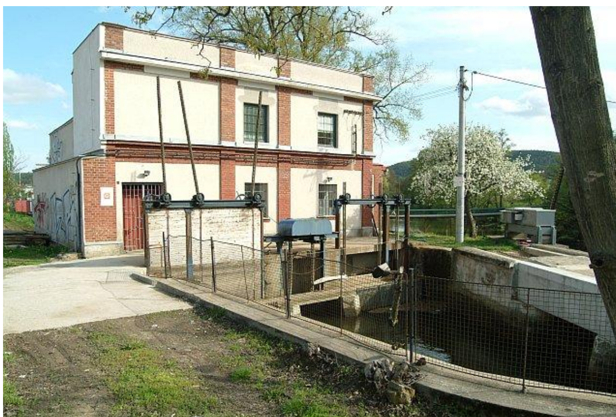
Obr. 1.10.2 Pohled na vtokový objekt MVE Komín - Brno [12]
