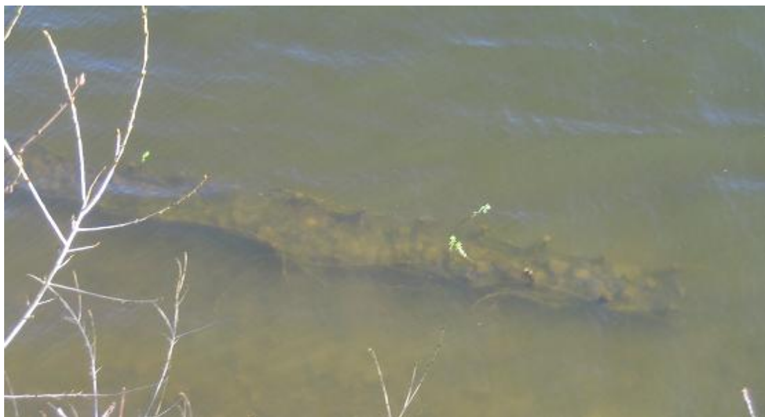
Obr. 2.1.1.1 Dvouřadý zápleťový plůtek vyplněný kamenným záhozem
