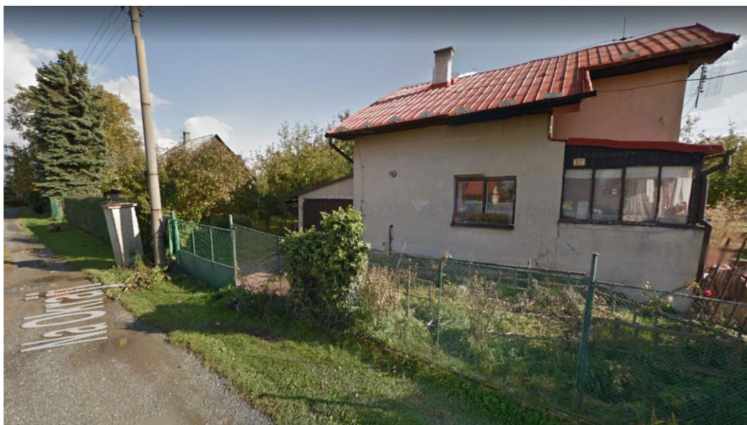
Obrázek číslo 68 – ulice Na Okraji č. p. 397, k. ú. Radošovice – Říčany, minulost Zdroj: Google Maps
