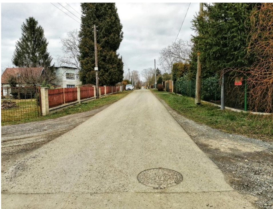
Obrázek číslo 65 – ulice Na Okraji, k. ú. Radošovice – Říčany (jedna z mála zpevněných komunikací) Zdroj: Vlastní fotodokumentace ze dne 9. 3. 2020
