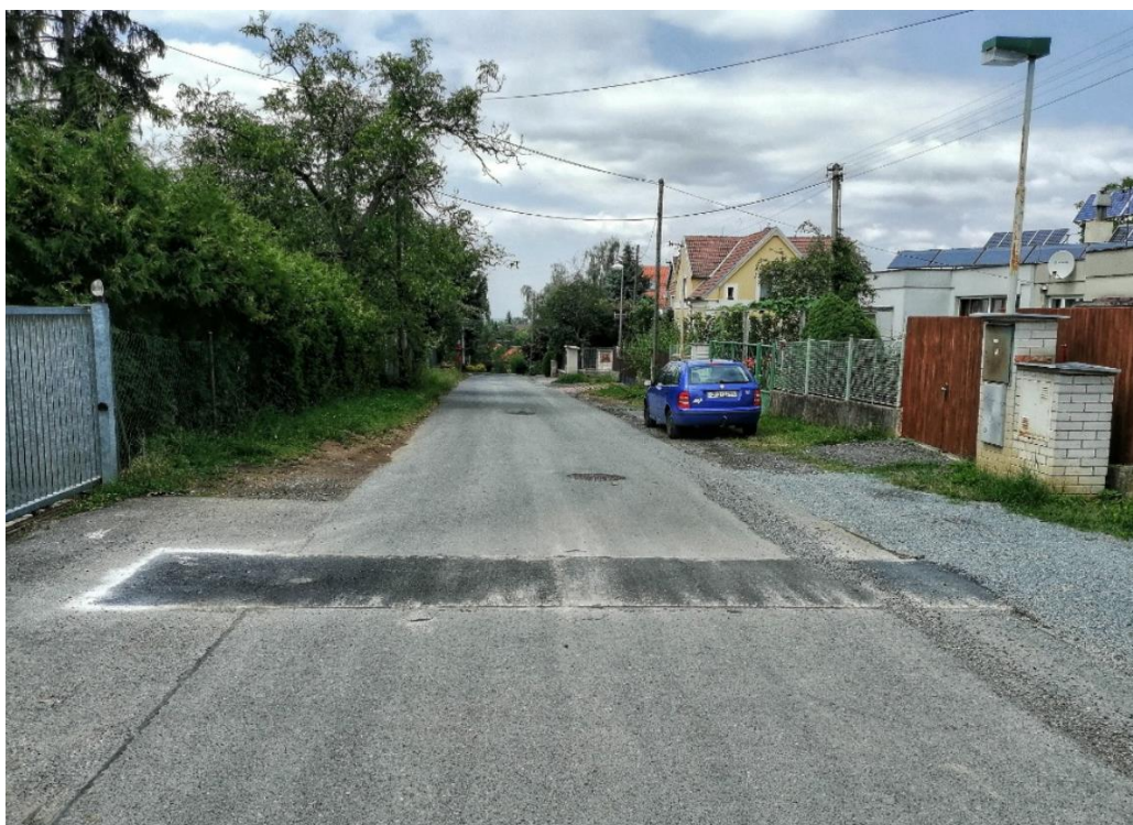
Obrázek číslo 66 – ulice Horní, k. ú. Radošovice – Říčany (v červenci opravovaná celá ulice)
