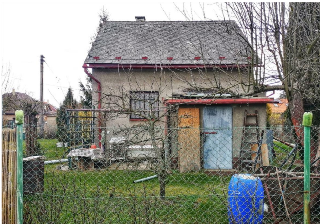
Obrázek číslo 58 – ulice Mezní, k. ú. Strašín u Říčan Zdroj: Vlastní fotodokumentace ze dne 12. 3. 2020
