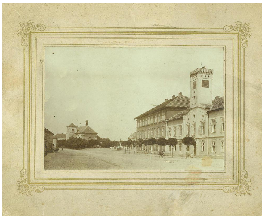
Obrázek číslo 44 – Masarykovo náměstí s kostelem sv. Petra a Pavla (před rekonstrukcí věže)
