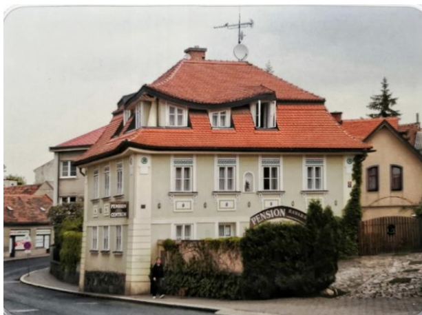
Obrázek číslo 10 – dnešní penzion Centrum, ulice 17. listopadu, Říčany Zdroj: Město Říčany, 2009
