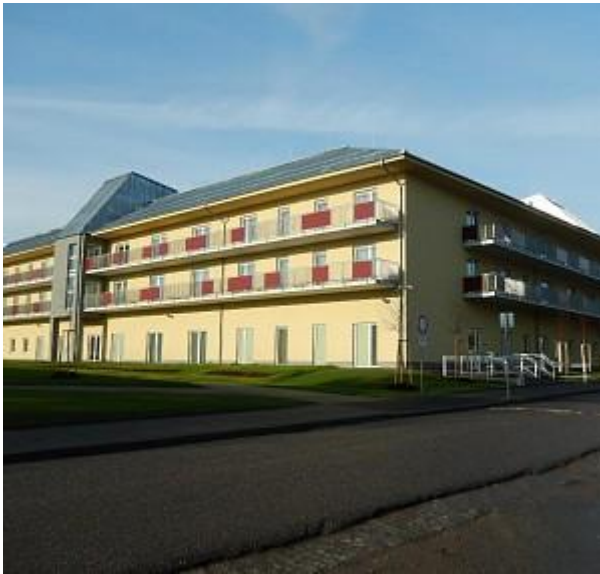
Celkový pohled na objekt Domova seniorů Bechyně.
