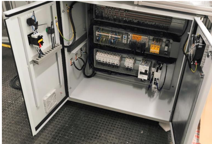
Obr. 84) Reálná podoba rozvaděče
