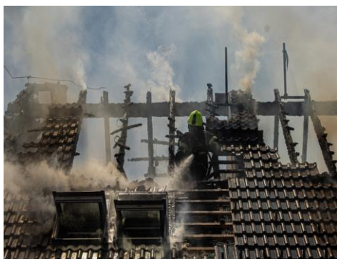
Obr. 24 – Rozebírání střešní konstrukce [45]
