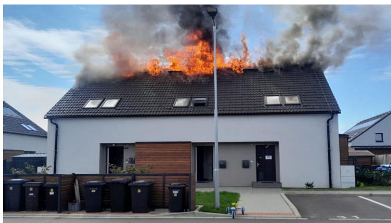
Obr. 23 –Požár střechy řadového domu [45]
