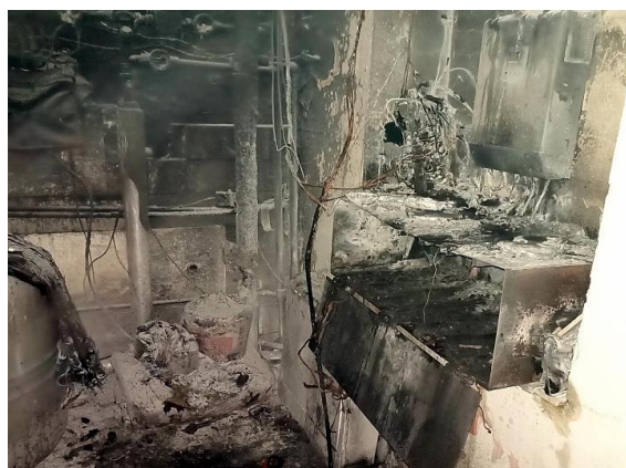
Obr. 22 – Ohořelé bateriové uložístě [42, 43]
