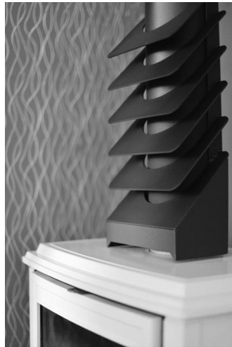
Obr. 27 Žaluzie umístěné na kouřovodu [36]
