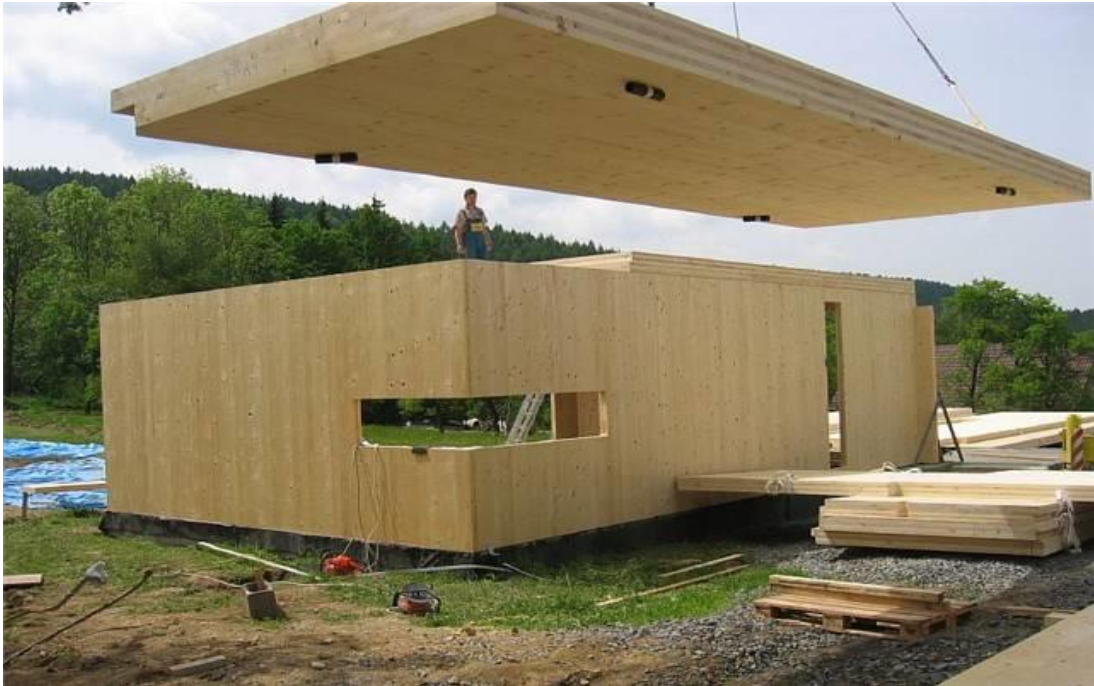
Obr. 9 Montáž rodinného domu z KLH panelů (ABETE, 2015)
