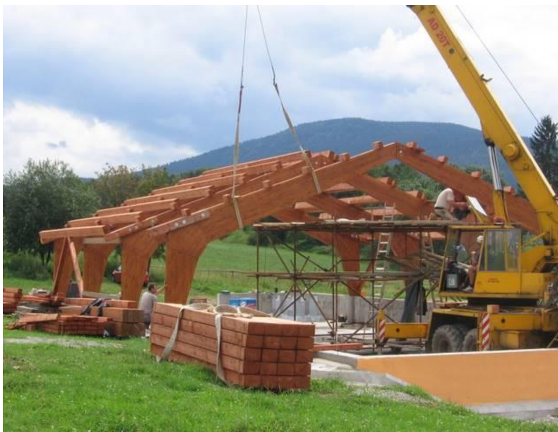
Obr. 10 Montáž nosné konstrukce ovčína Dlouhá Stropnice (TESKO, 2015)
