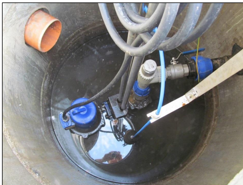
Obr.č.3.6 Domová čerpacia jímka v obci Hrádek
