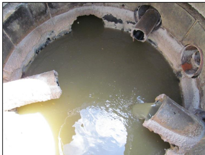
Obr.č.4.1 Výustná šachta na ČOV
