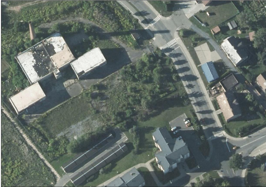
Obr.17: Ortofoto snímek areálu bývalé teplárny z roku 2012. (ČUZK)
