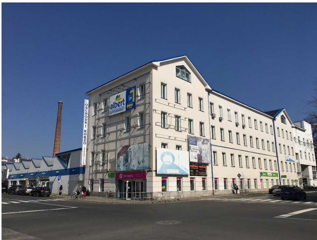
Obr.15: Současný stav areálu bývalého Moravolenu (2022). (ČUZK)
