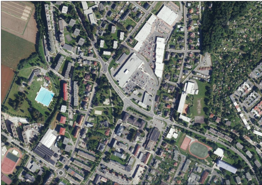
Obr.22: Ortofoto snímek areálu bývalých kasáren z roku 2021. (ČUZK)
