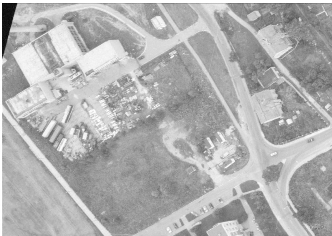
Obr.16: Ortofoto snímek areálu bývalé teplárny z roku 1997. (ČUZK)
