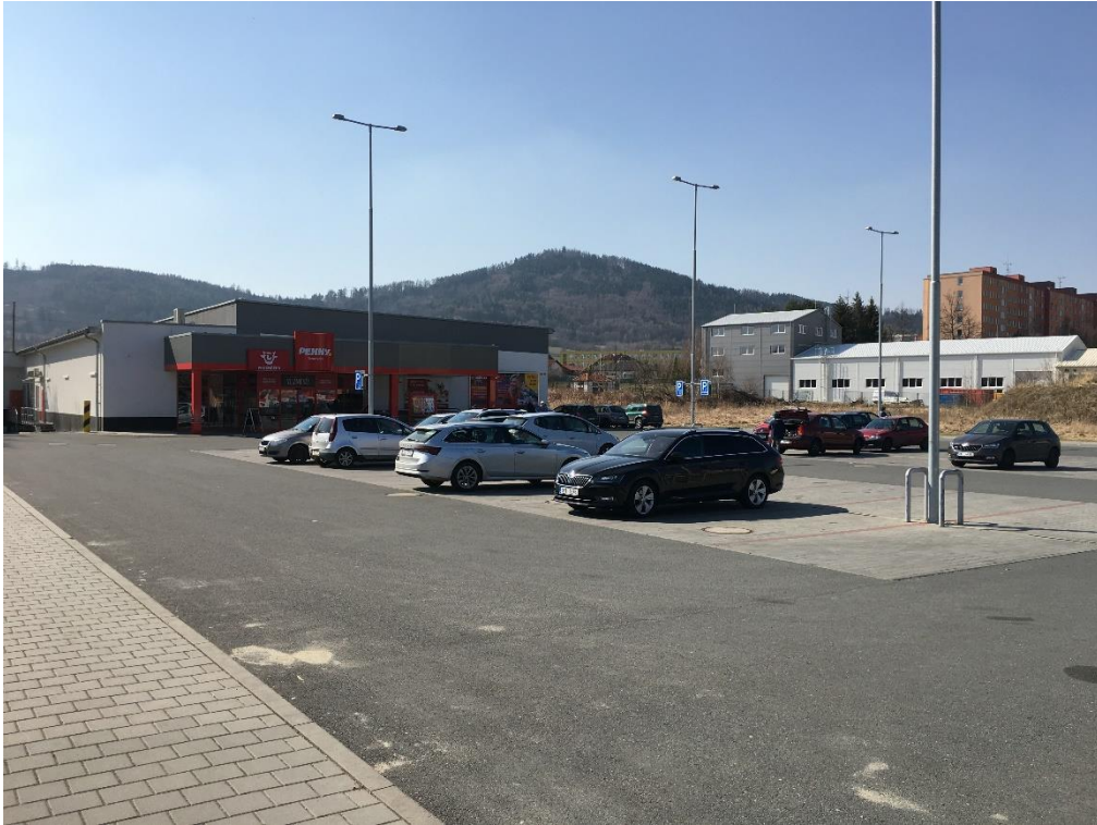
Obr.19: Současný stav areálu bývalé teplárny (2022). (ČUZK)
