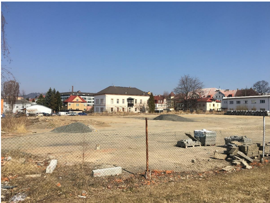
Obr.31: Současný stav areálu bývalé Hedvy (Lautnerova, Žerotínova) (2022).
