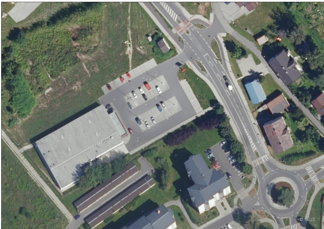
Obr.18: Ortofoto snímek areálu bývalé teplárny z roku 2021. (ČUZK)
