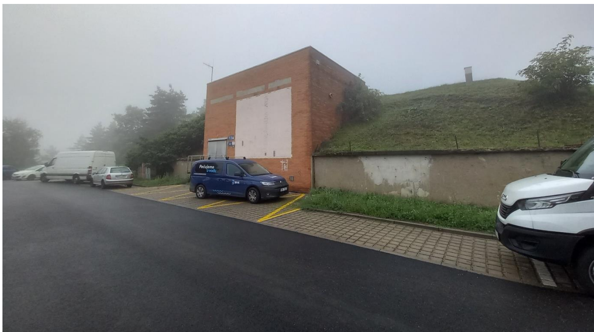
Obrázek 33: Zemní vodojem Kohoutovice
