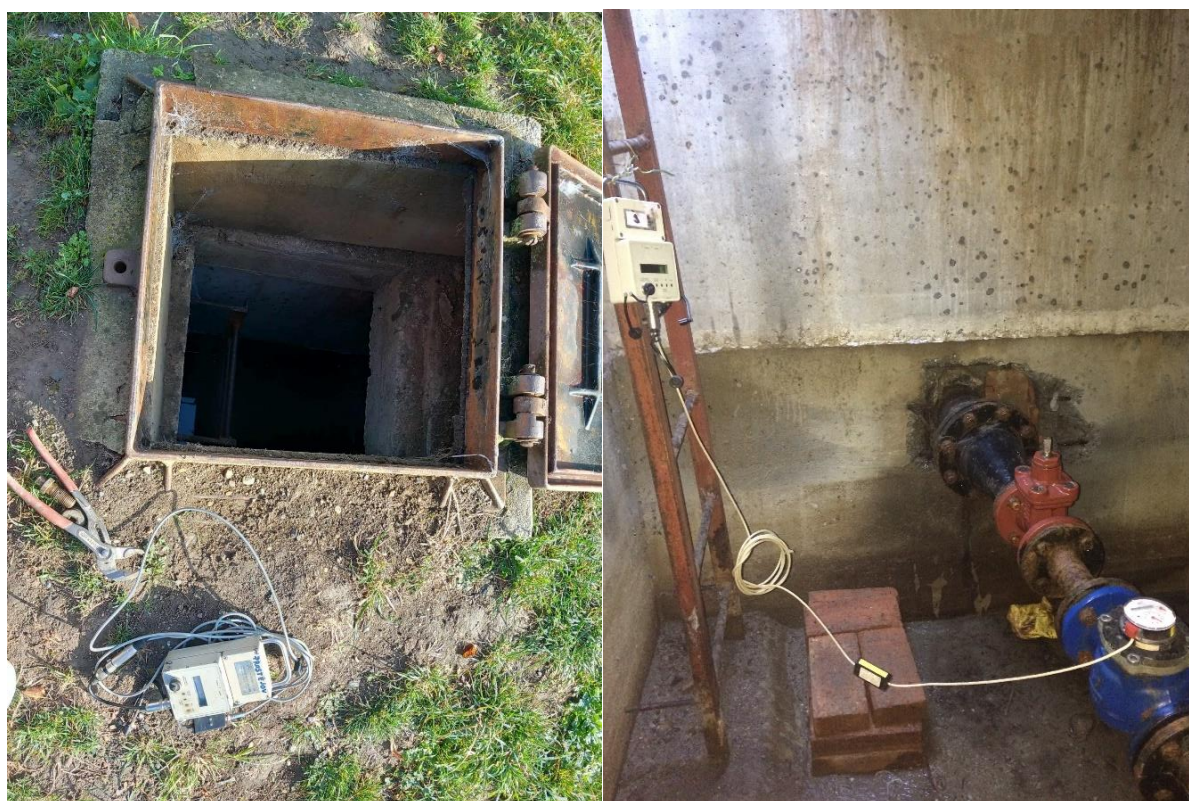
Obrázek 64: Vodoměrná šachta v Tučapech (vlevo) a instalace dataloggeru v šachtě (vpravo)
