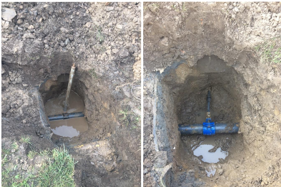
Obrázek 67: K poruchám zde dochází nejčastěji v místech spojů
