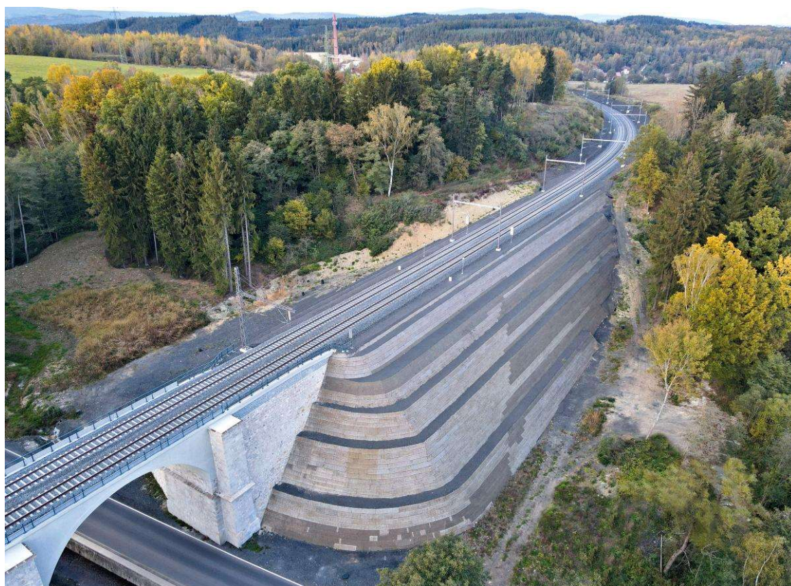
Obrázok 4.10: Finálne prevedenie sanácie úseku Hájek – Dalovice [10].
