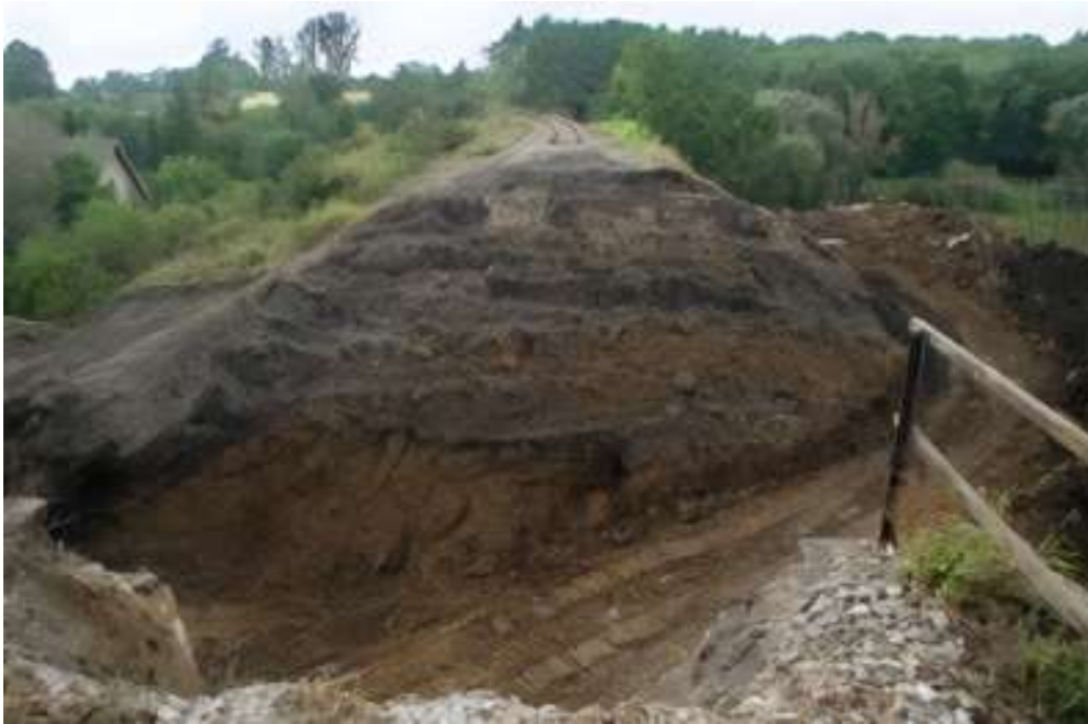
Obrázok 4.14: Postupné odťazovanie telesa násypu [16].
