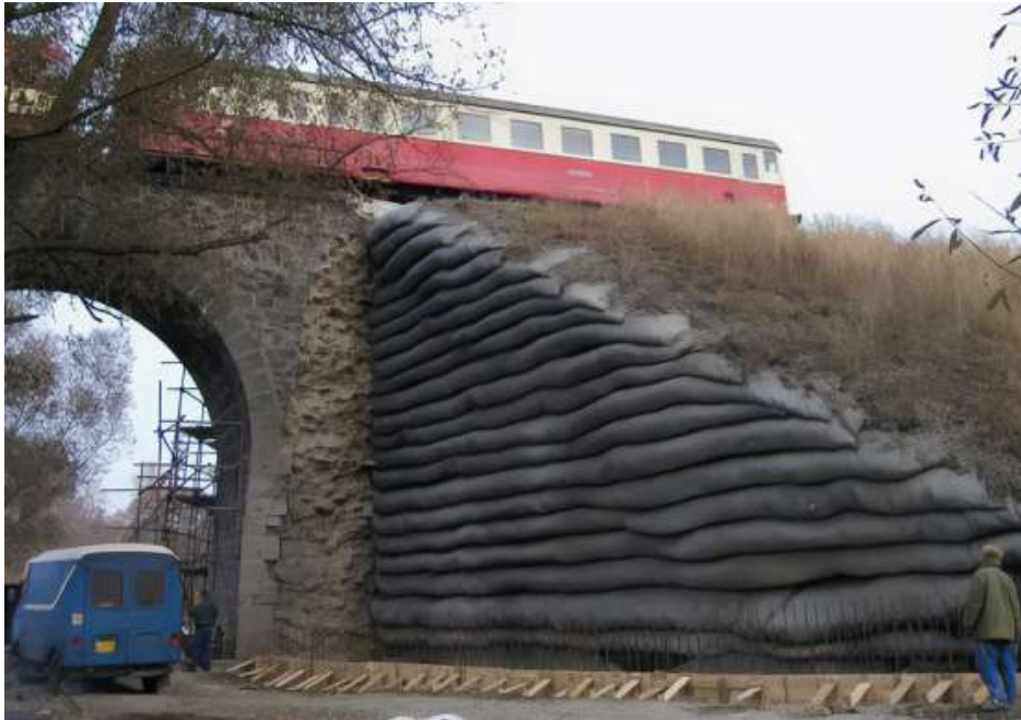
Obrázok 4.18: Odbúrané krídlo mostu pred finálnym dokončením [16].
