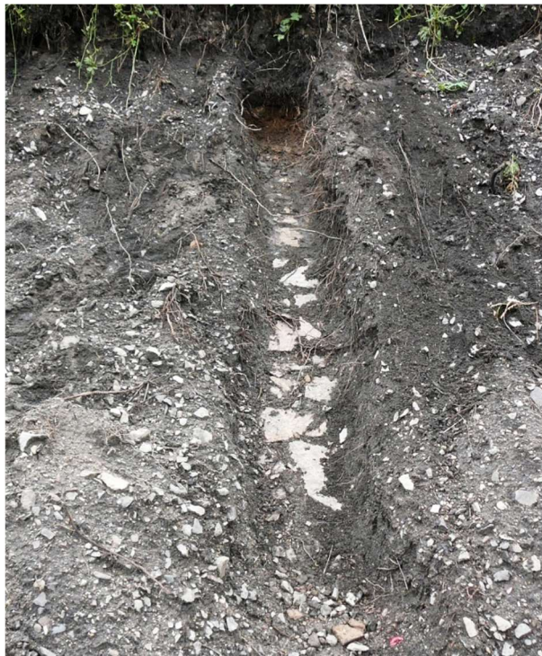
Obrázok 4.20: . Viditeľné opevnenie pôvodného telesa dráhy [18].
