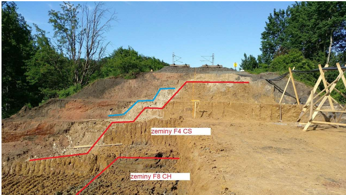
Obrázok 4.5: Priečný rez telesom pôvodného násypu a prísypu [9].
