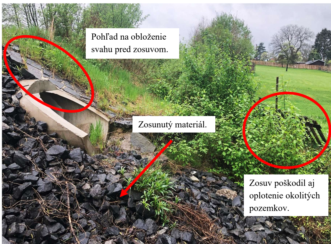
Obrázok 7.5: Bližší pohľad na zosuv – jednotlivé detaily sú popísané v samotnom obrázku.
