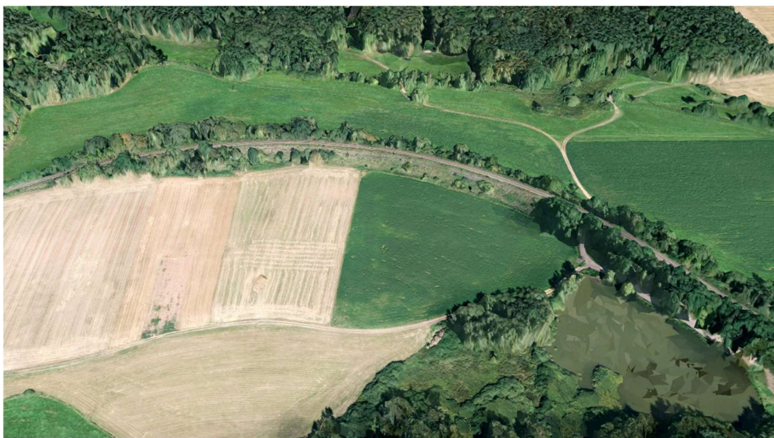
Obrázok 4.25: Letecká 3D snímka problematického úseku v obci Pastuchovice [22].
