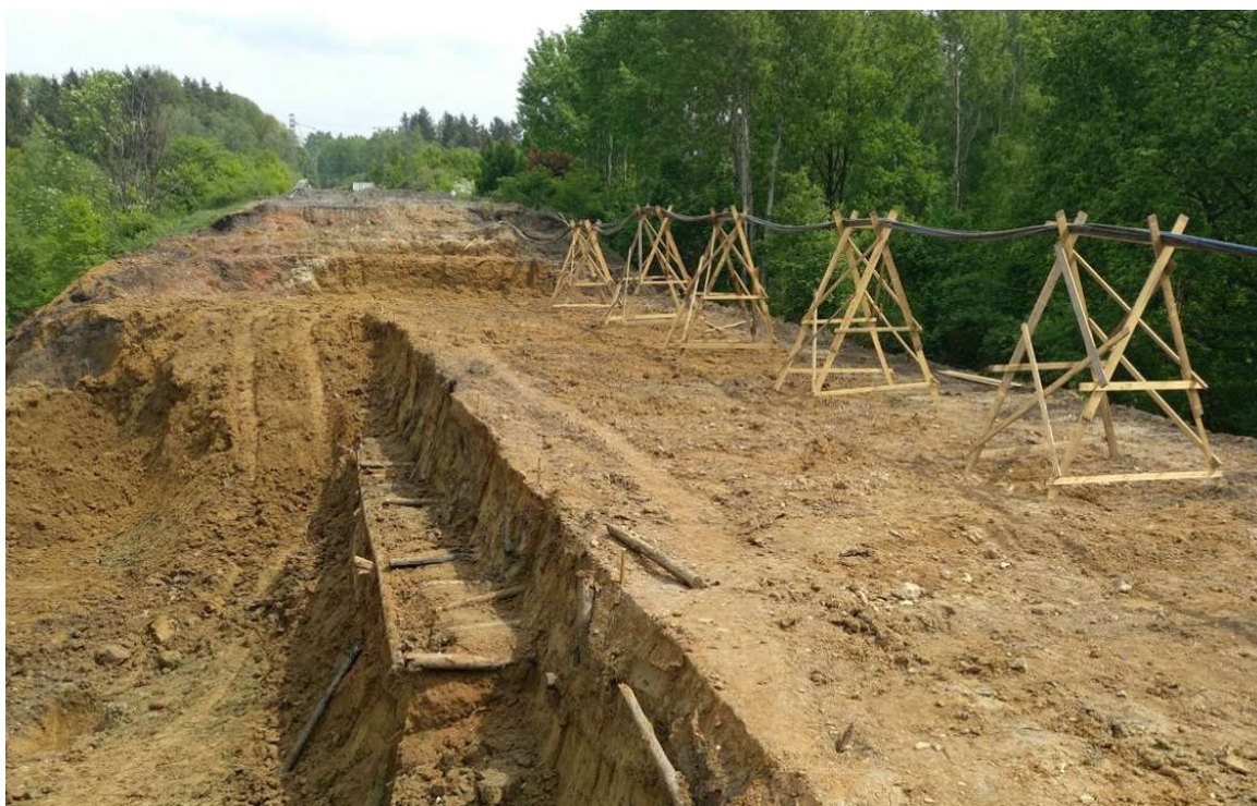
Obrázok 4.4: Drevené lešenia (tzv. bárkové konštrukcie) z roku 1873 [9].
