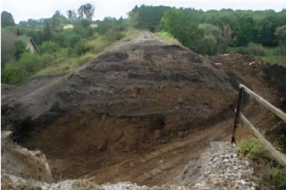
Obrázok 4.14: Postupné odt'azovanie telesa násypu [16].
