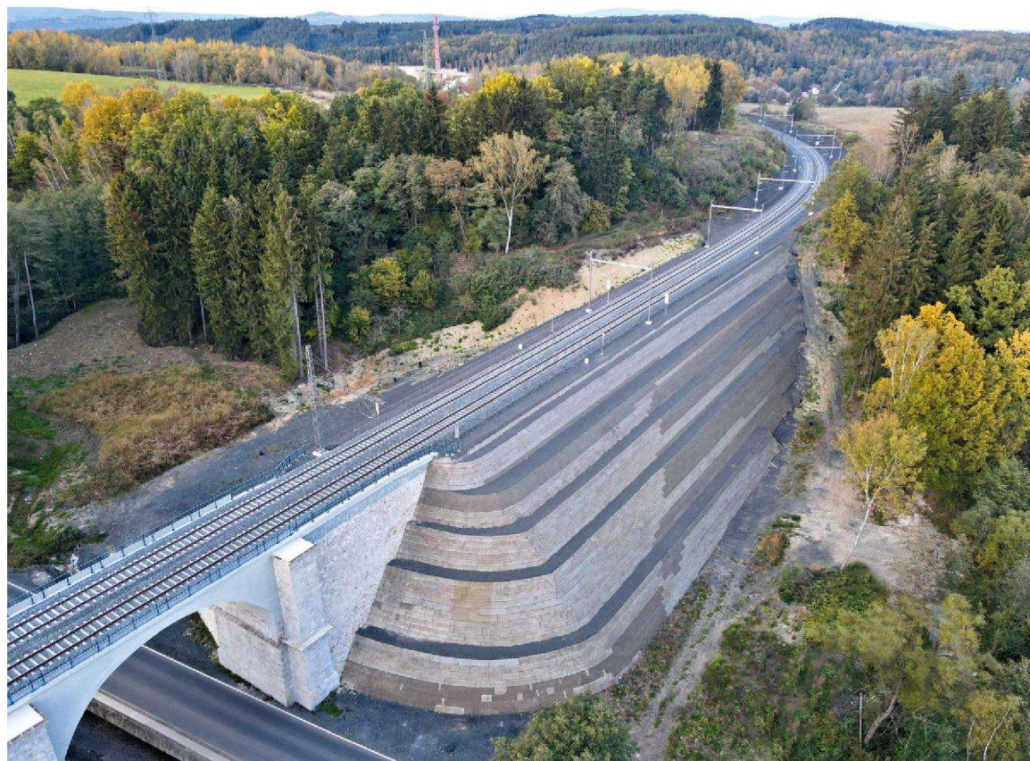
Obrázok 4.10: Finálne prevedenie sanácie úseku Hájek – Dalovice [10].
