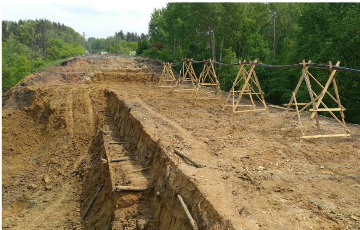
Obrázok 4.4: Drevené lešenia (tzv. bárkové konštrukcie) z roku 1873 [9].
