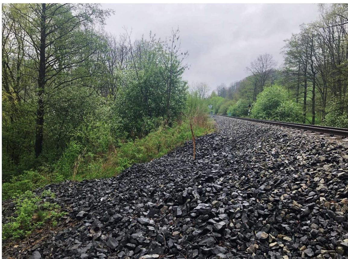
Obrázok 7.3: Pohľad po zosuve na ľavú stranu trate v smere staničenia (smer stanica Mlýny).
