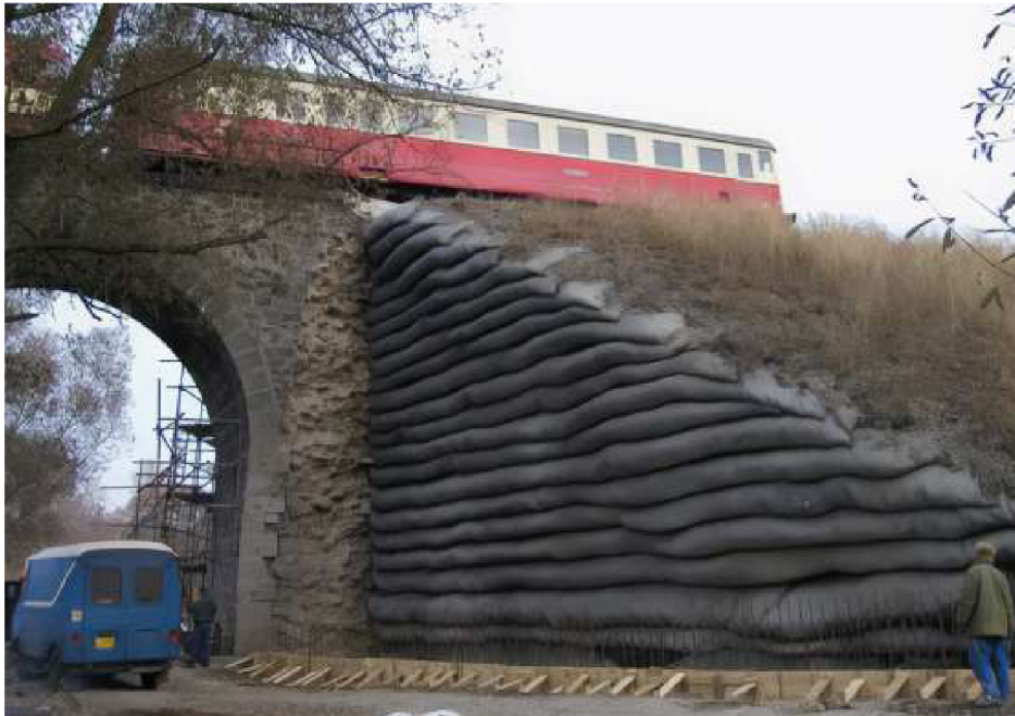
Obrázok 4.18: Odbúrané krídlo mostu pred finálnym dokončením [16].
