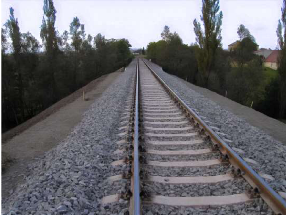
Obrázok 4.16: Pohľad na železničný zvršok a násyp po dokončení [16].
