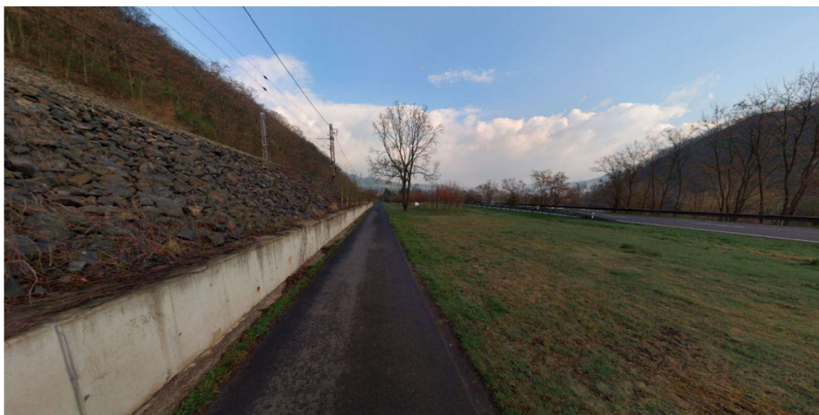
Obrázok 4.23: Pohľad na pravý svah (v smere staničenia) násypu po prevedenej sanácii [19].
