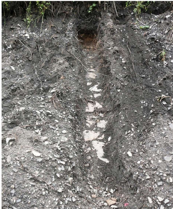
Obrázok 4.20: . Viditeľné opevnenie pôvodného telesa dráhy [18].
