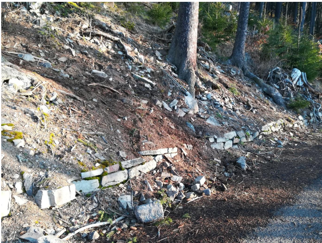
Obr. 16: Svahová porucha
