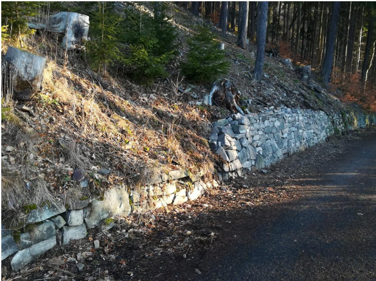
Obr. 14: Opěrná zeď před (vlevo) a po (vpravo) opravě
