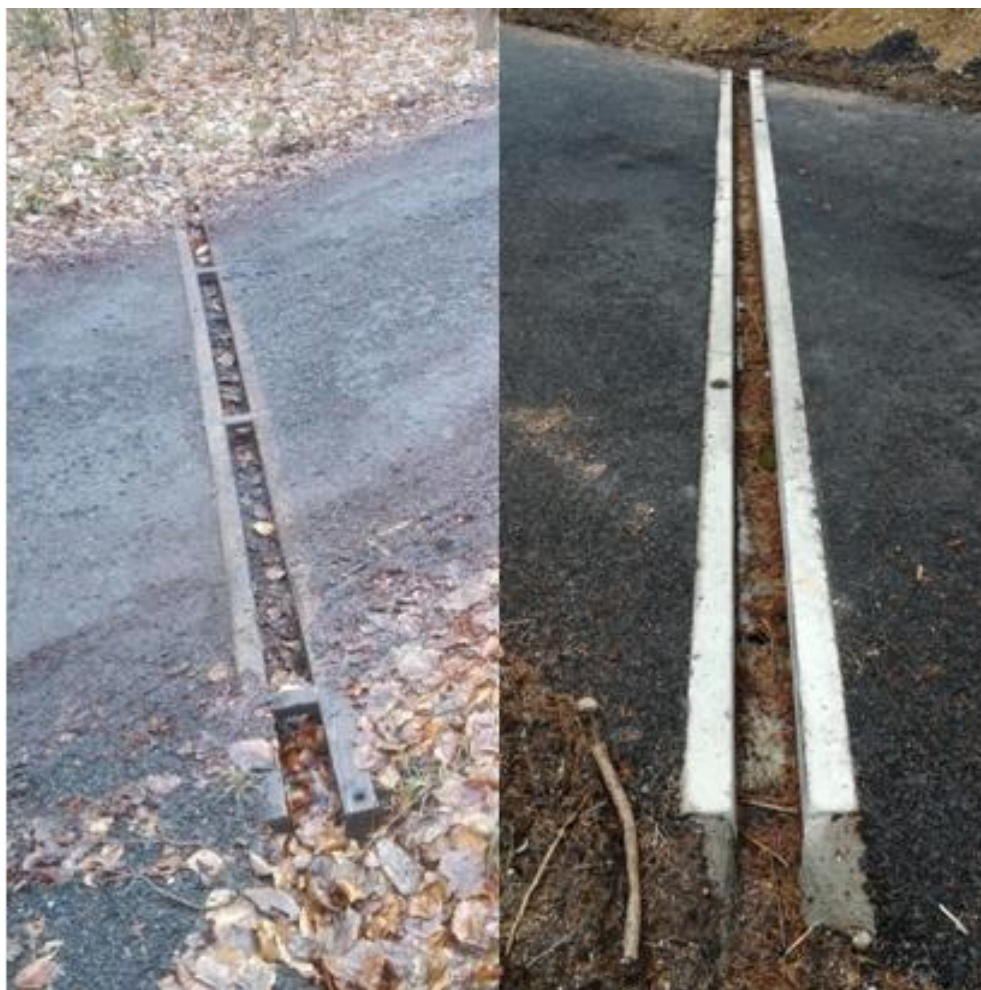
Obr. 10 a 11: Dřevěná svodnice (vlevo), betonová svodnice (vpravo)
