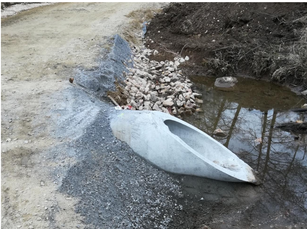
Obr. 13: Stavba nového propustku
