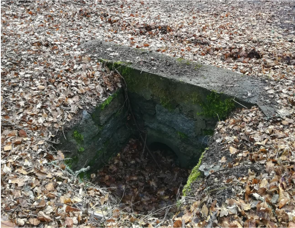
Obr. 12: Zanesený propustek
