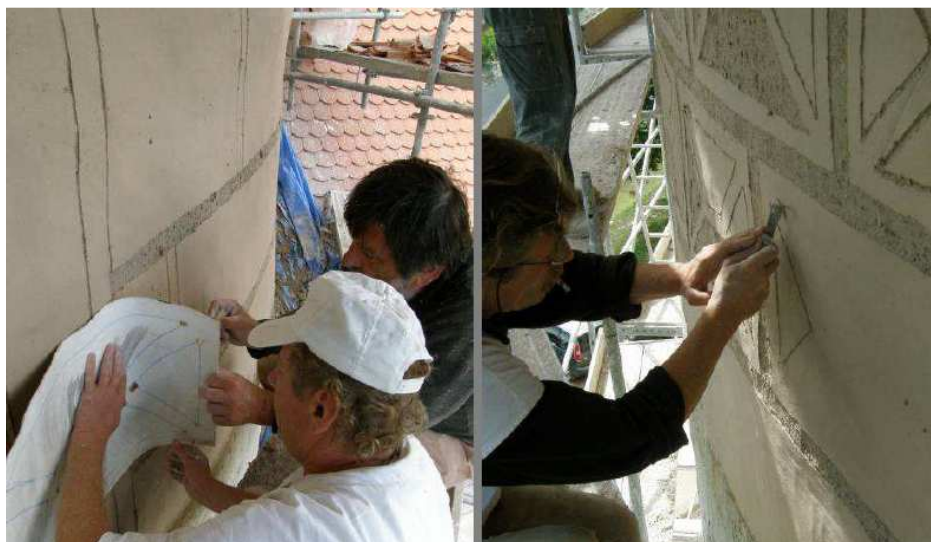
Obr. 2: Práca na jednovrstvovom sgrafite, hrad Bauska v Lotyšsku [15]
