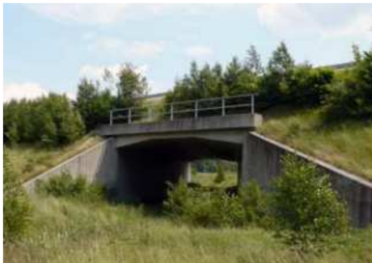
Obr. 13: Migrační objekt – podchod na dálnici D5 v úseku Plzeň – Rozvadov (Anděl et al., 2011)
