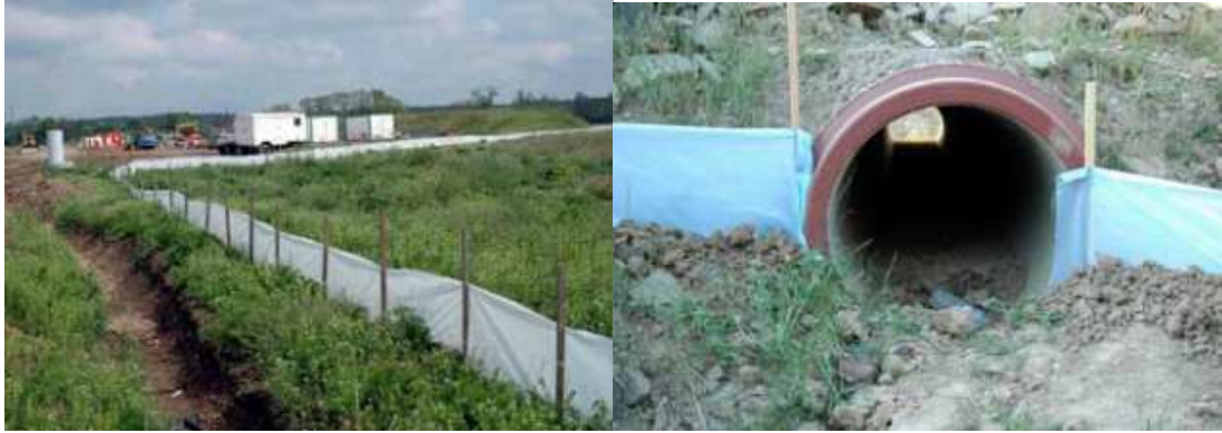
Obr. 20: Vlevo přechodná bariera pro obojživelníky, vpravo migrační objekt (Anděl et al., 2011)
