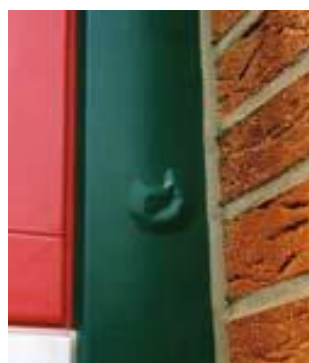
Obrázek č. 17 Vodový puchýř na rámu (převzato z [21])
