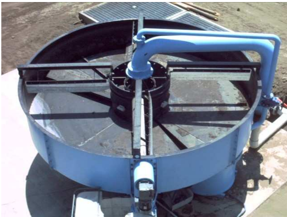
Obr. 2: Kruhová flotačn í nádr ž
