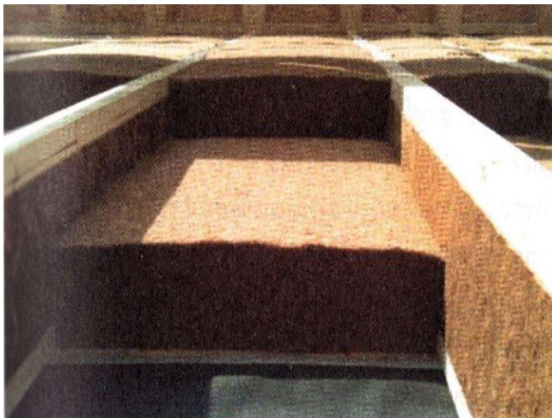
Obrázek 9 - Dřevovláknitá izolace STEICO [19, str.51]
