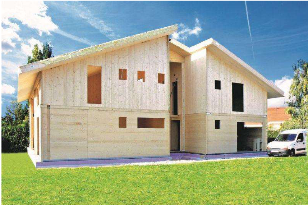
Obrázek 3- Stavba z CLT panelů [6]
