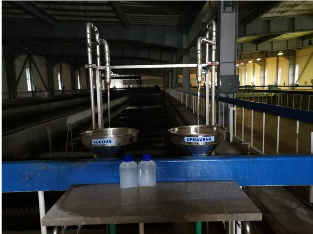
Obrázek č. 9. Místo odběru upravené a surové vody Stanovice. (Fotografie vlastní)
