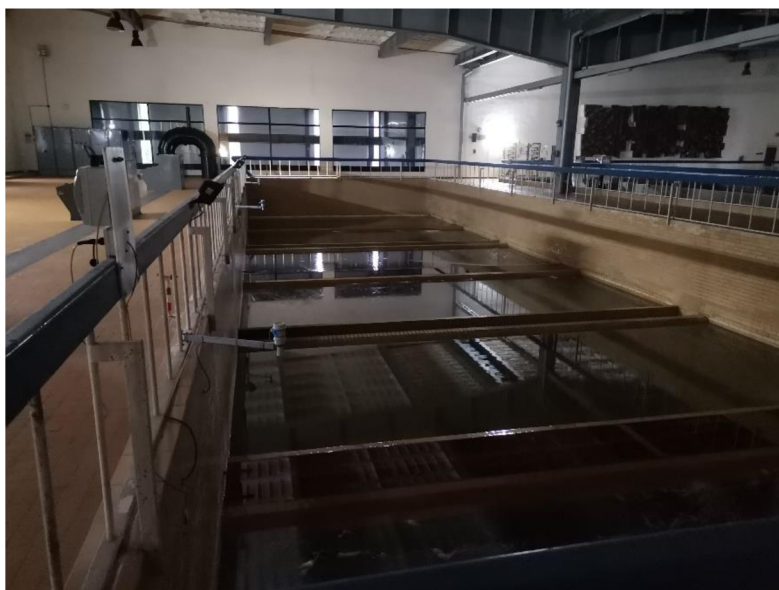
Obrázek č. 4. Pískové filtry – Březová. (Fotografie vlastní)
