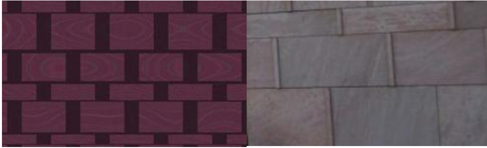
Obrázek 5-16 Textura zdi na budově B
