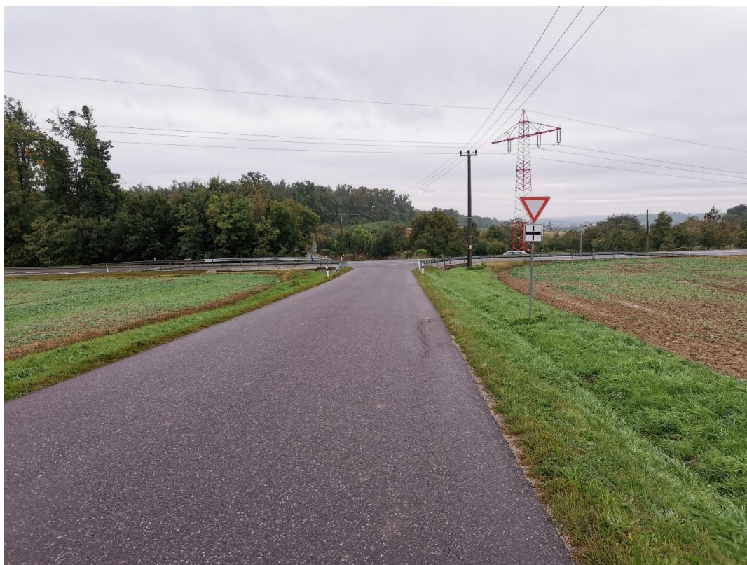
Obrázek 14 - Příjezd ke křižovatce od obce Žerůtky
