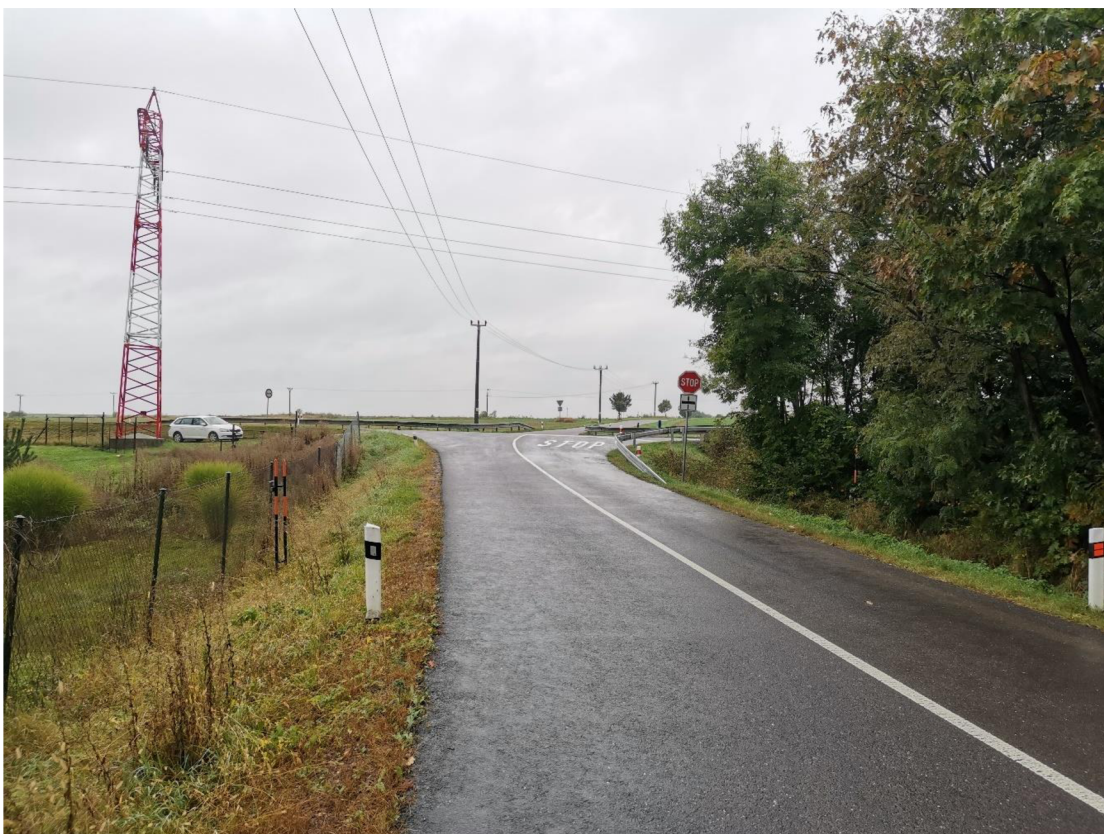
Obrázek 12 - Příjezd ke křižovatce od obce Kravsko
