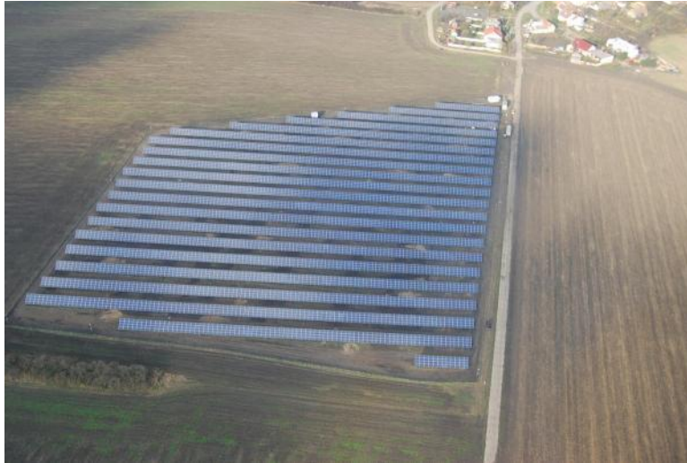
Obr. 5. Elektrárna Žeraviny. Zdroj: http://www.zeraviny.cz/
