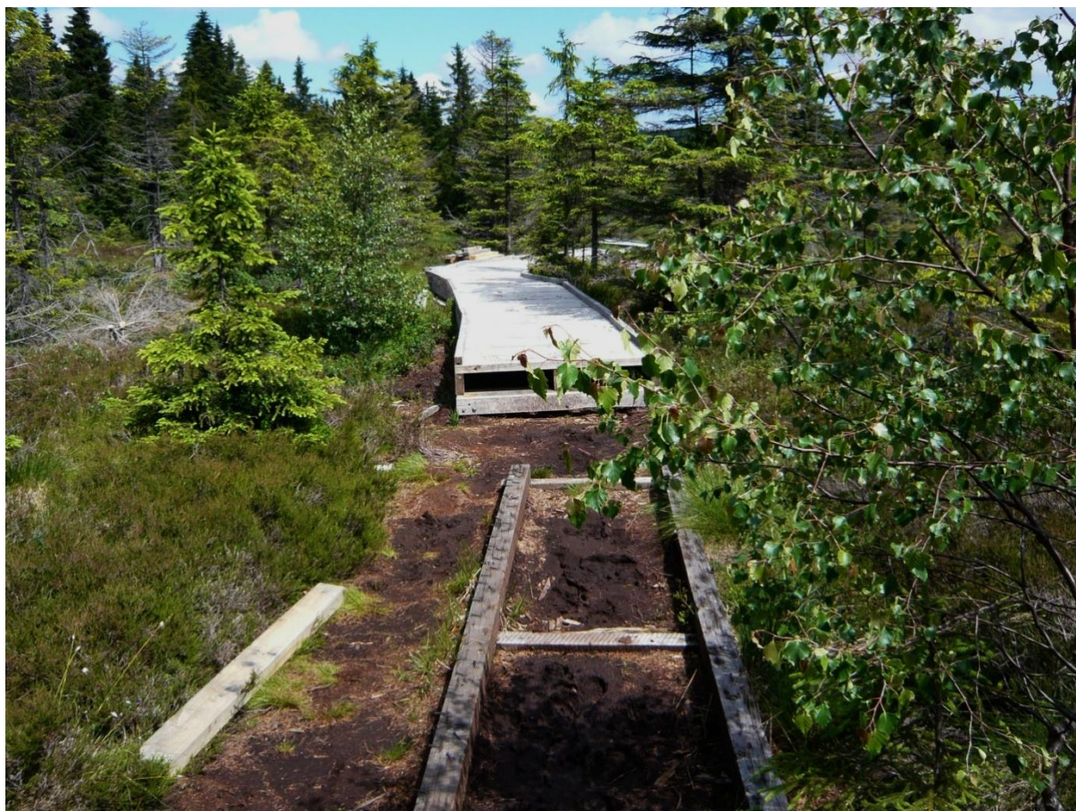
Obr. č. 4: Rozestavěná naučná stezka nedaleko zastávky č. 11
