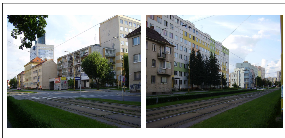
Obr.47, 48 Sídliskové priestory so dopravnou, obchodnou a inou funkciou Foto: Holub Peter
