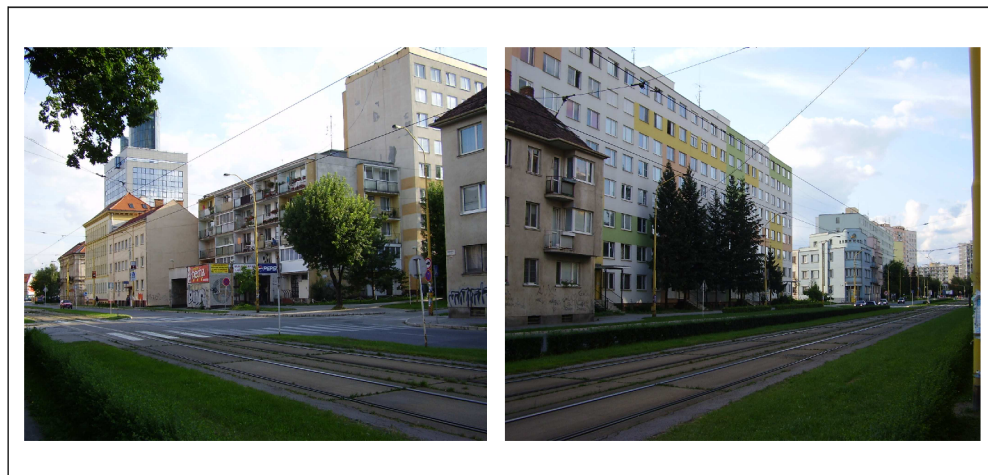
Obr.47, 48 Sídliskové priestory so dopravnou, obchodnou a inou funkciou Foto: Holub Peter
