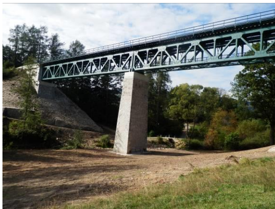
Obr. č. 2 Železniční most, vlastní zdroj
