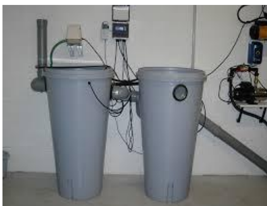
Obr. 5 Příklad umístění technického zařízení na čištění šedých odpadních vod Aqualoop ( www.asio.cz )
