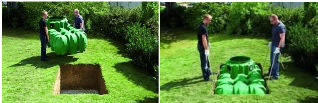
Obr. 2 Příklad uložení vsakovacího objektu do země (www.tzb-inbo.cz)
