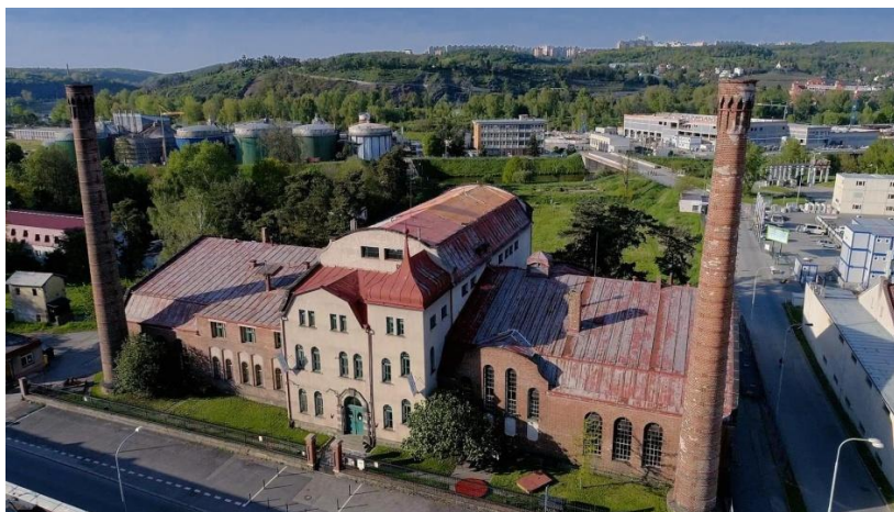
Obr. 3.6: Čistírna odpadních vod v Bubenči [13]
