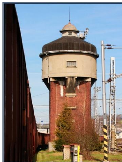
Obr. 3.3: Drážní vodojem ve Valašském Meziříčí (r. 2014) [7]
