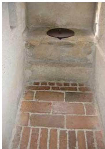
Obr. 3.5: Prevét na hradě Švihov – vnitřní pohled [10]
