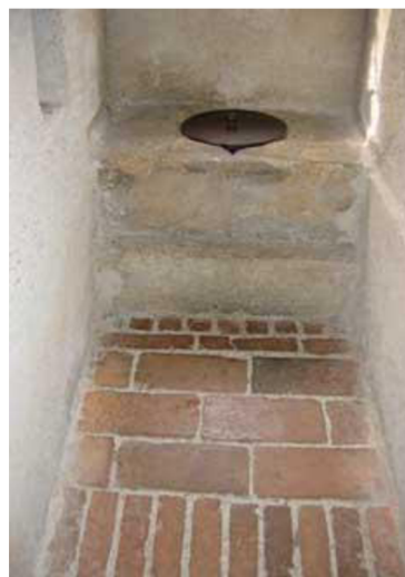
Obr. 3.5: Prevét na hradě Švihov – vnitřní pohled [10]
