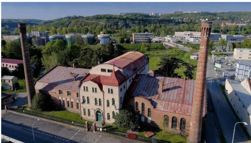
Obr. 3.6: Čistírna odpadních vod v Bubenči [13]
