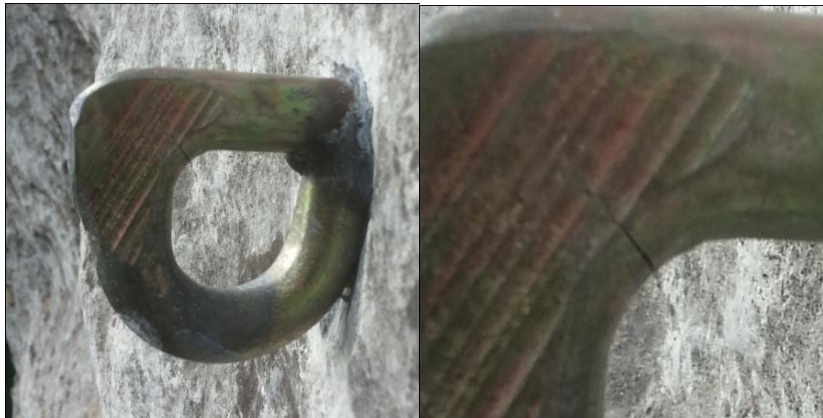
Obr. 3.11 Kotva prvotně určená pro využití ve stavebnictví s viditelnou trhlinou [autor]
