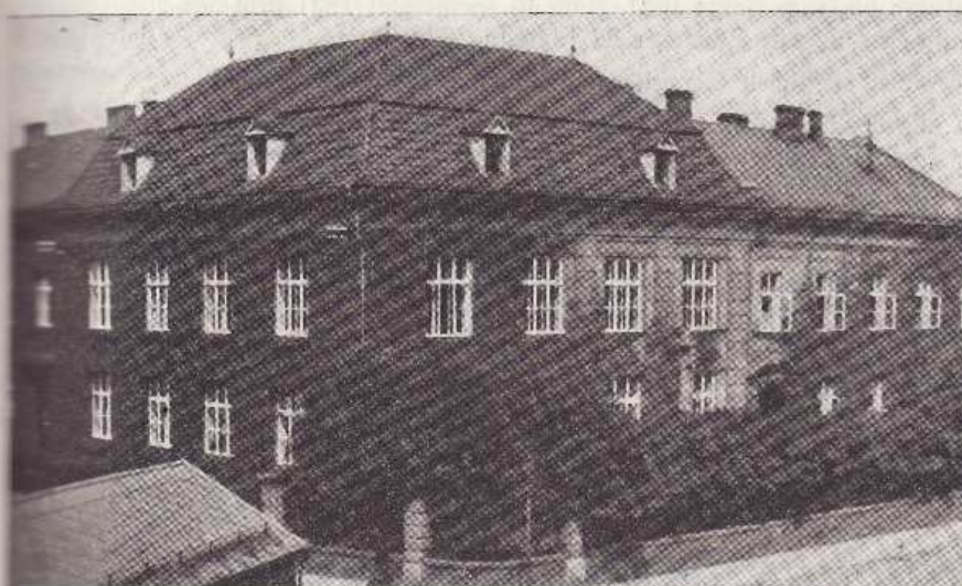
Waisenhaus nach dem Umbau. Ansicht Ede Neustraße.
