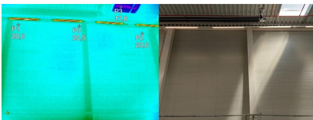
Příloha 49 Termovizní měření v interiéru, stěna na severní straně, střed, spodní část
