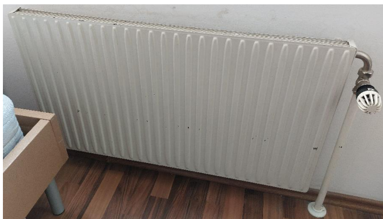
Obrázek 7 Deskový výměník
