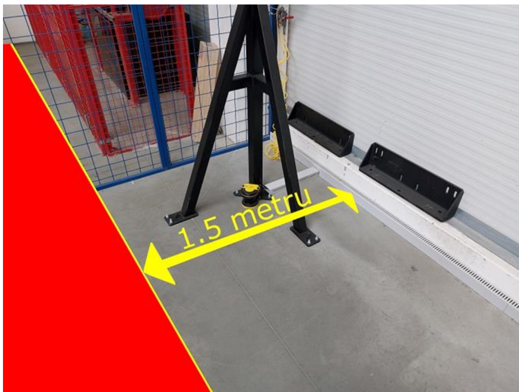
Obrázek 35 Vizualizace části podlahy, která není zateplená
