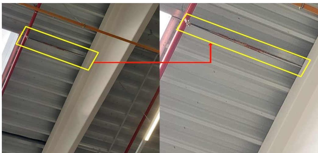
Obrázek 60 Kaz, trapézový plech
