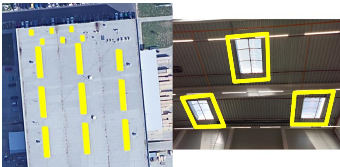
Obrázek 29 Řešené světlíky nad výrobní částí objektu
