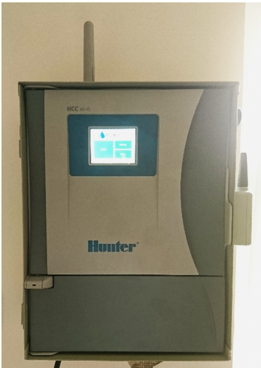
Obrázek 2 Ovládací ústředna Hunter HCC se softwarem Hydrawise (zdroj: vlastní archiv)
