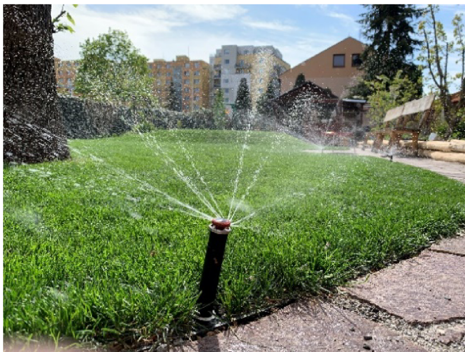
Obrázek 17 Postřikovač Pro-Spray s tryskou MP Rotator (zdroj: vlastní archiv)
