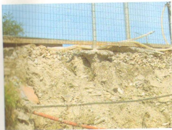
Svah mezi tenis. kurtem a pož. nádrží ( pozemek parc.č. 18/2)
