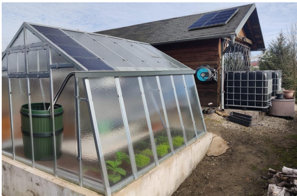
Obr. 2 Představa možného provedení PV a závlahového systému s panely umístěnými na střeše skleníku Limes a vedlejší budovy a možným provedením vnitřní i vnější akumulace vody; foto z archivu autora, upravené generativním nástrojem „AI inpainting“ dostupného na webu LightX [4]
