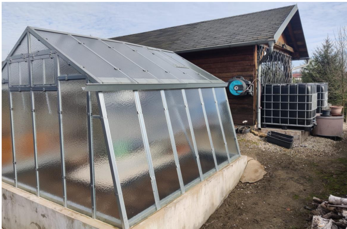
Obr. 28 – Ukázka okapového systému společnosti Limes s.r.o. v blízkosti okolní zástavby s možností sběru, akumulace („IBC“ nádrž na pravé straně) a využití dešťové vody. Foto z archivu autora.
