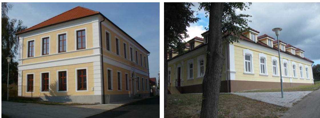
Výměna oken a oprava fasády ZŠ Římov a centrum seniorů Plav
