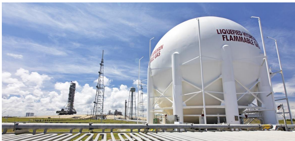
Obr. 18 Ukážka sférickej nádrže na kvapalný vodík [18]
