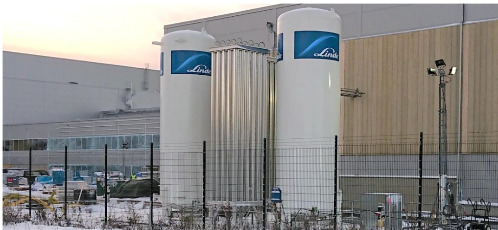
Obr. 17 Ukážka vertikálnych valcových nádrží s výparníkom
