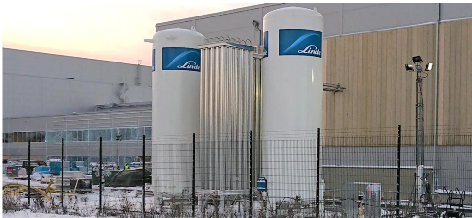
Obr. 17 Ukážka vertikálnych valcových nádrží s výparníkom
