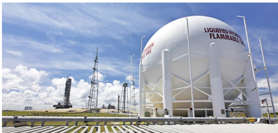
Obr. 18 Ukážka sférickej nádrže na kvapalný vodík [18]
