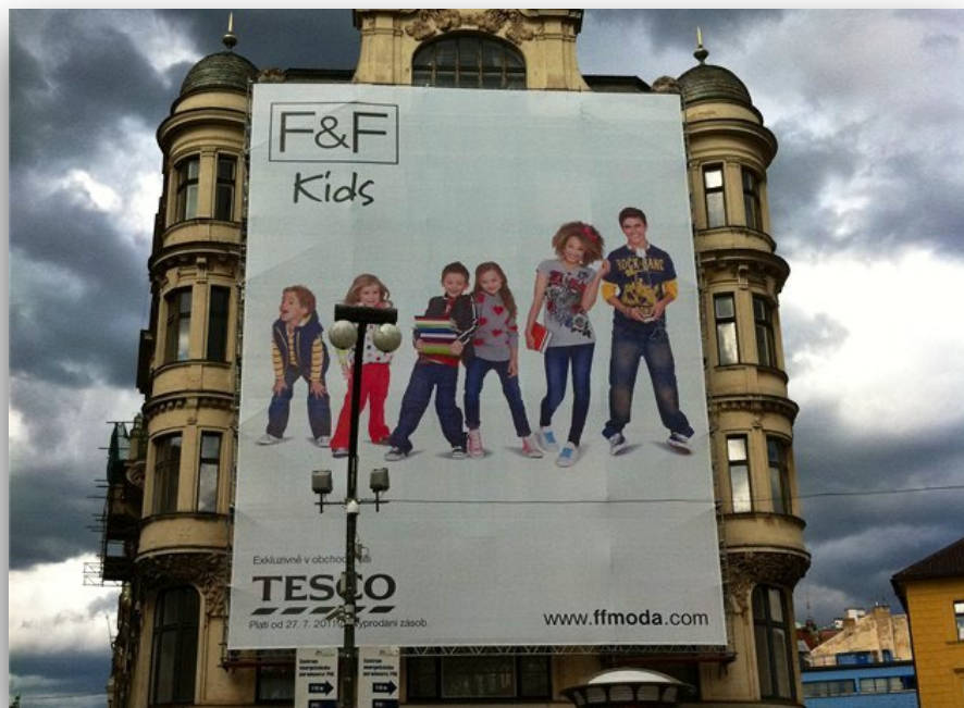
Obrázek 4 - Nevhodně umístěná reklama hyzdící historický dům na Jungmannově náměstí na Praze 1, jež musela být odstraněna dle nařízení vedení této městské části (zdroj: https://images.app.goo.gl/6CPp84Mqns3kyJe58 )
